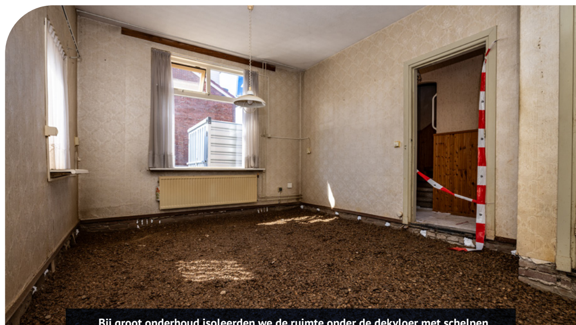
Bij groot onderhoud isoleerden we de ruimte onder de dekvloer met schelpen
