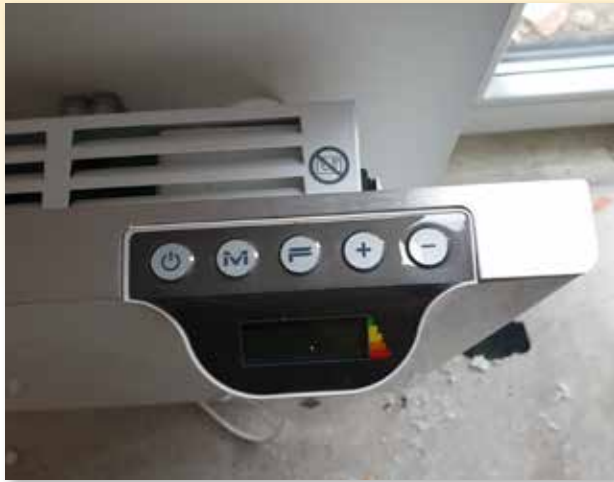
Bediening radiator slaapkamers
