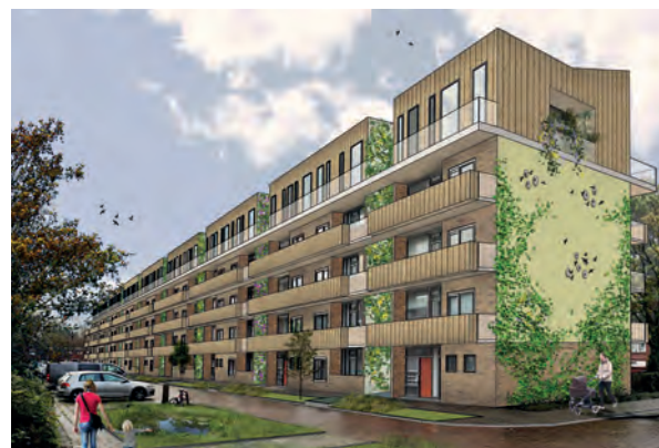
Waterlandpleinbuurt - De getransformeerde flat met portiektuinen op de plek van de oude trappenhuizen
